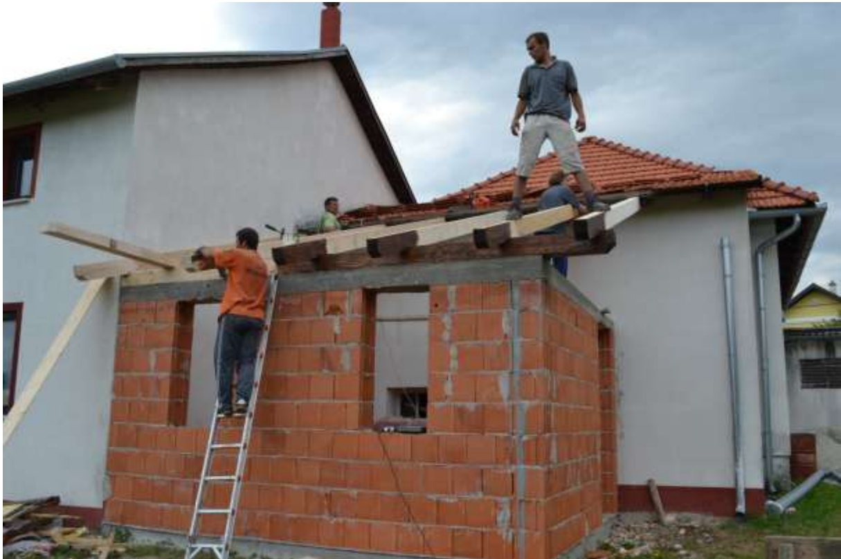
Gradnja prostorije za udruhu mladih
